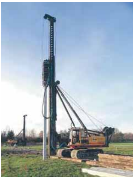
Abbildung 4.7: Ramm-pfahl (Bilde: enercret Röthis)
