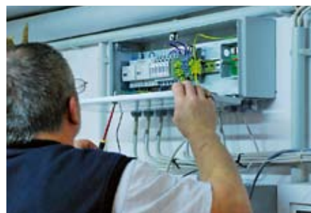
■ Bild 2: Inbetriebnahme des Elektroählerkastens bei einer Wärmepumpenanlage.
